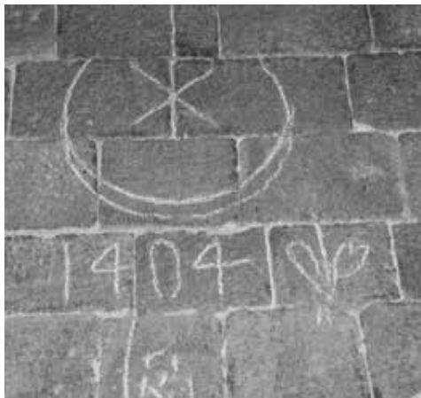
Arcidosso, Castello Aldobrandesco parete nord della Torre, (particolare).
