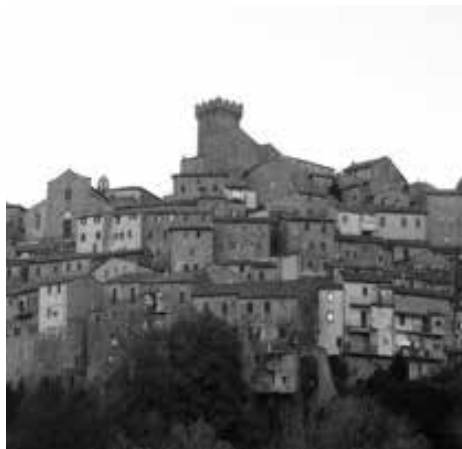
Arcidosso, veduta ovest
